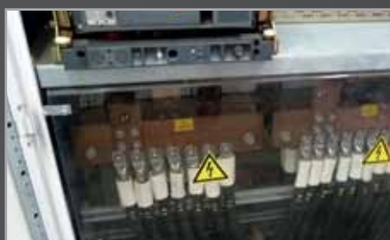
Schaltschrankbau control panel construction
