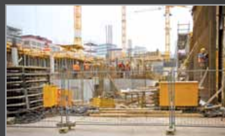
Hoch- und Tiefbau Civil engineering
